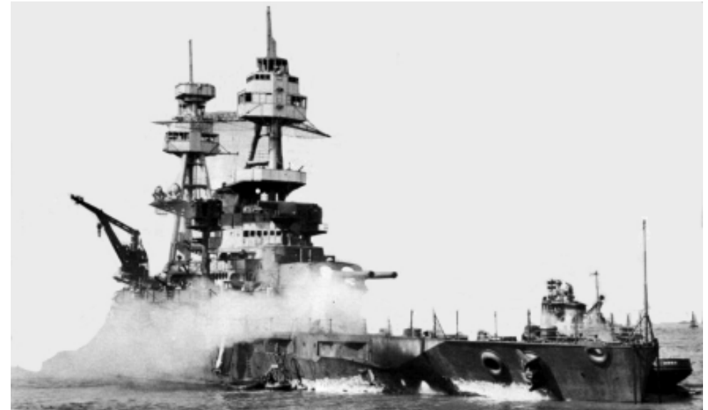
Pearl Harbor 7/12/1941: la USS Nevada è colpita da cinque bombe, ma non affonda grazie al tempestivo "Damage Control"
